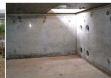
雨水ハウスの基礎下部の貯水タンク
